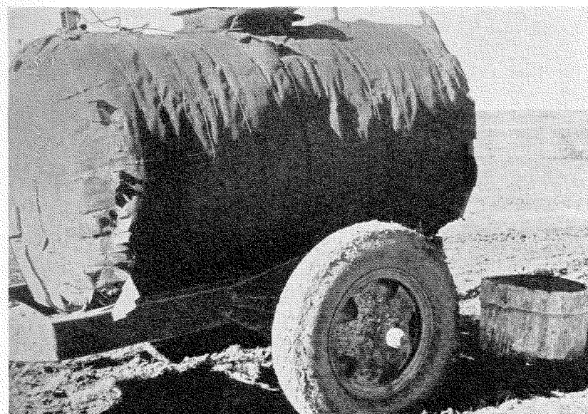
Fig. 15. Velisoleret vandvogn, der gjorde god fyldest i et tilfælde, hvor der var nem adgang til varmt vand, men en forholdsvis lang transportvej.
